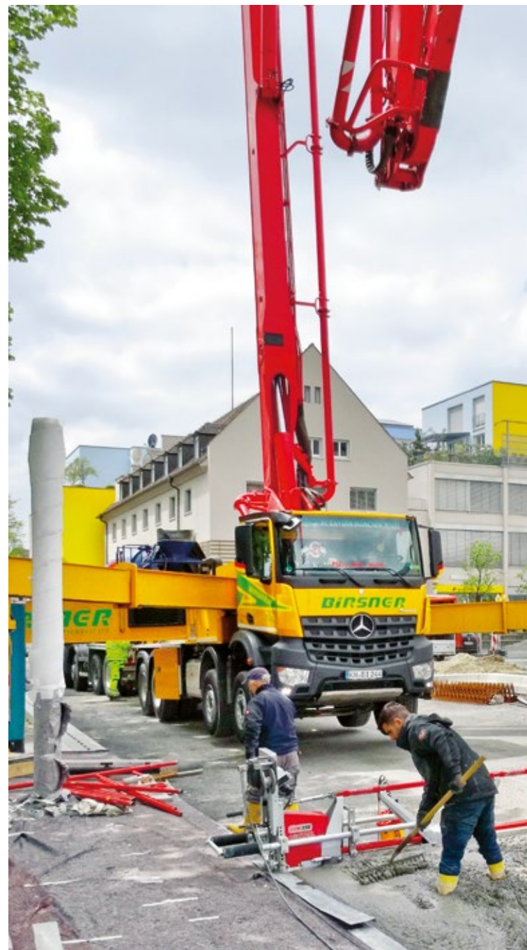
Einbringen des Betons mit Pumpe
