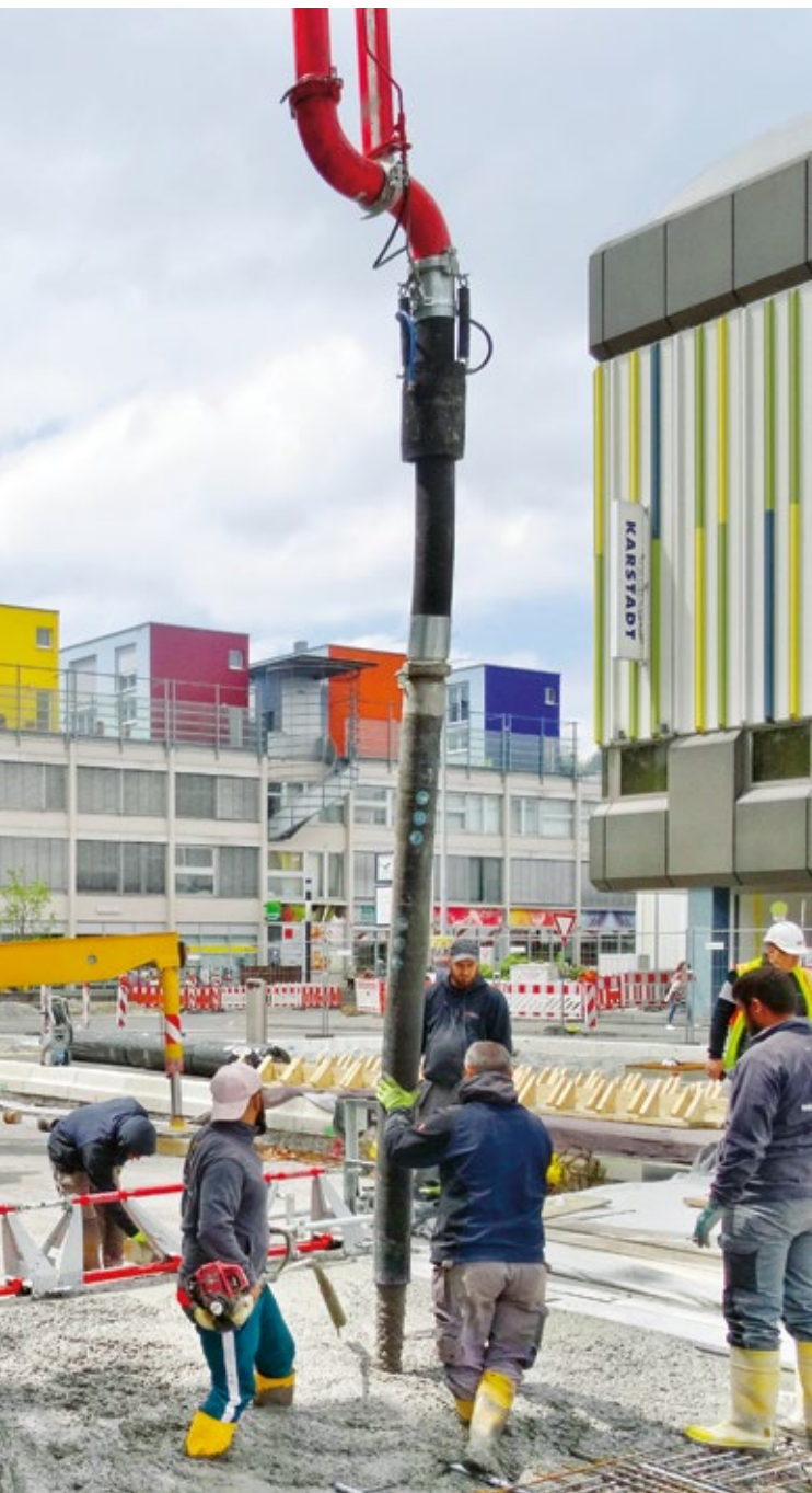
Einbringen des Betons mit Rutsche und Rüttelbohle
