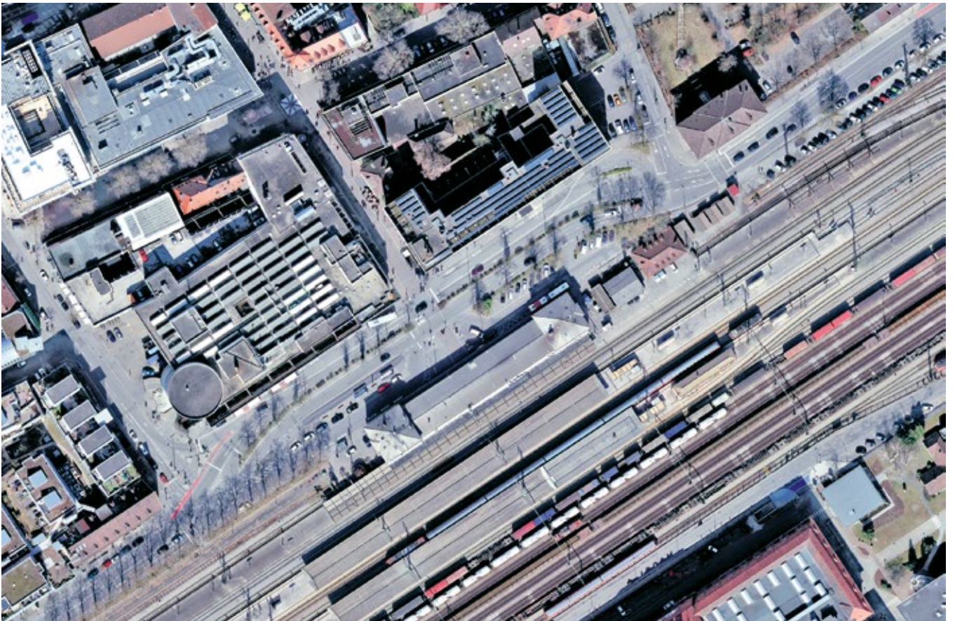
Zentraler Omnibusbahnhof in Singen: Luftbild vor dem Umbau
