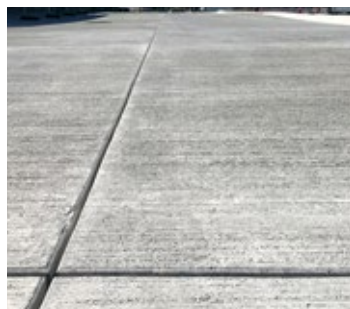
Geschnittene, noch unverfüllte Fuge
