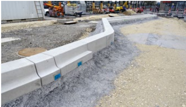
Klassisch mit «Rückenstützenbeton» («Kasseler Borde»)
