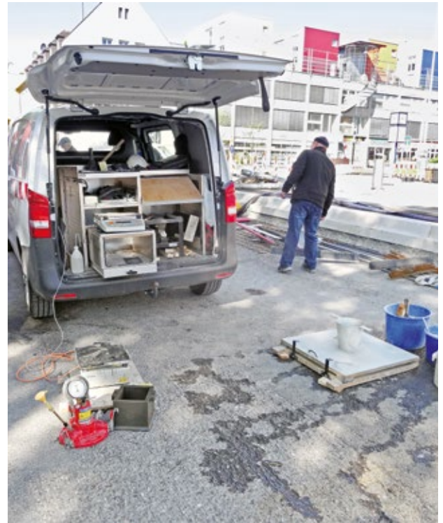
Frischbetonkontrollen auf der Baustelle mit Laborwagen
