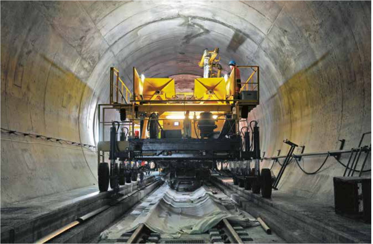
Abbildung 13: Das Betonshuttle fährt auf dem Tunnelbankett ©TTG
