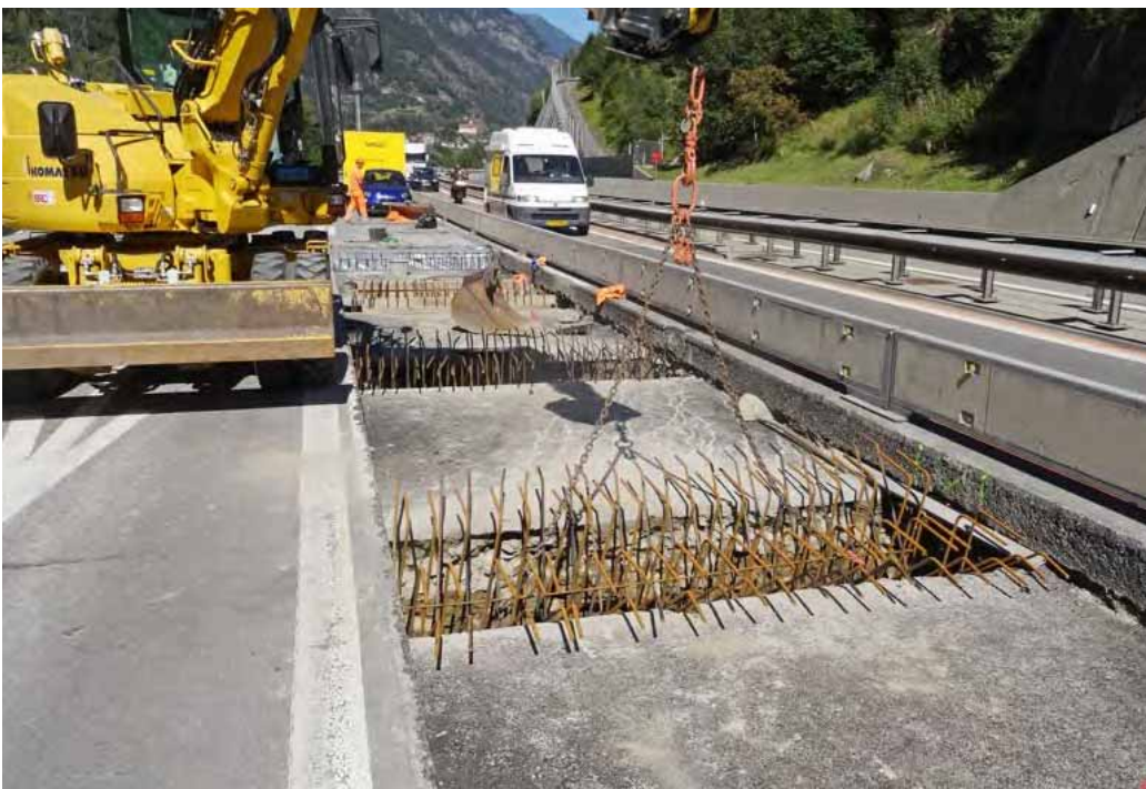
Bewehrung der Endverankerungen
