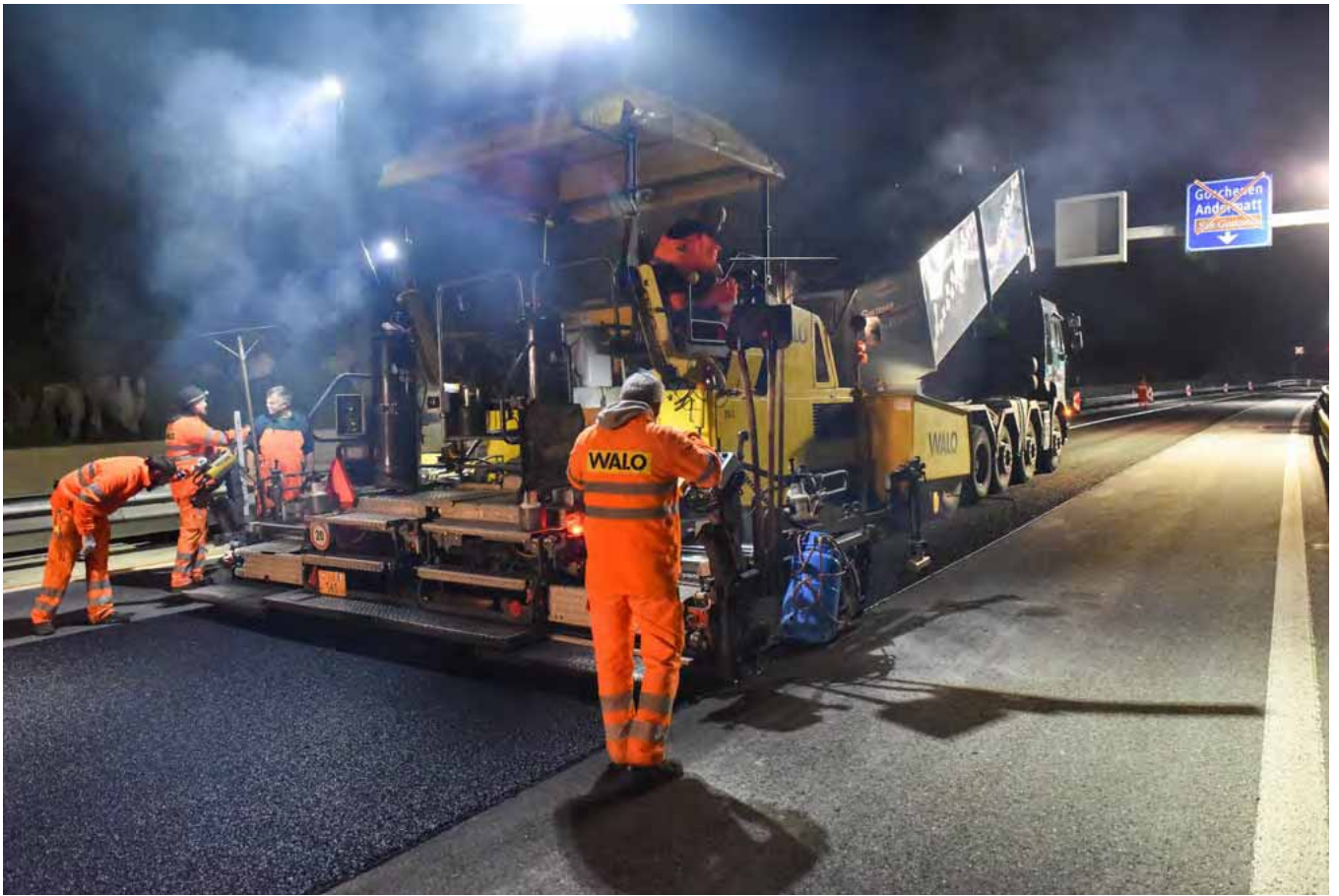
Deckbelagseinbau SDA 8-12
