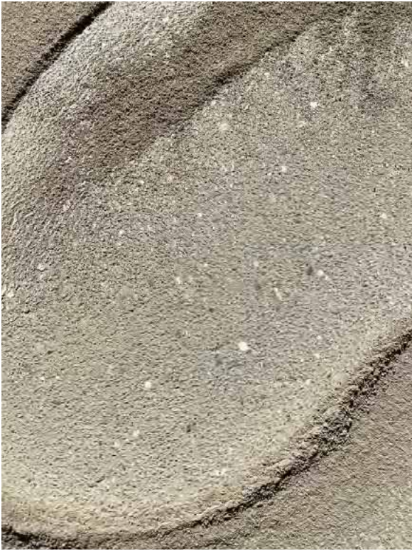
Betonoberfläche verzögert und Zementhaut entfernt (ausgebürstet)
