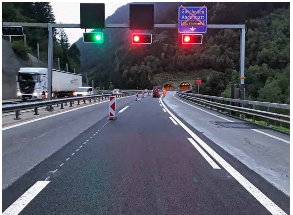
Bereit für die Verkehrsfreigabe (Blick Fahrtrichtung Süden)
