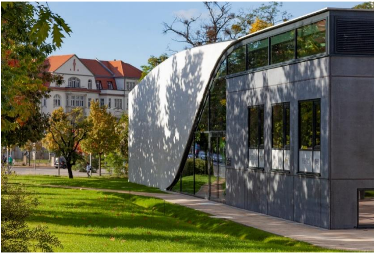
Der aus Carbonbeton gefertigte „Cube“ in Dresden (Foto: Stefan Gröschel, IMB, TU Dresden)
