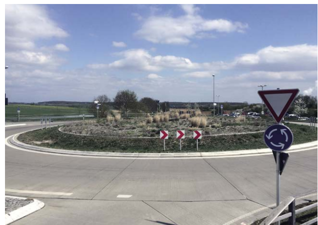
Bild 2: Betonfahrbahndecke im kommunalen Straßenbau
