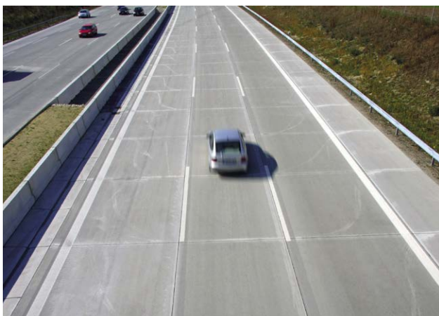
Bild 1: Betonfahrbahndecke im Fernstraßenbau
