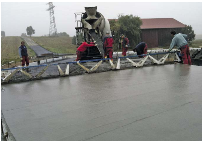
Bild 6: Herstellung einer Beton-Kreisverkehrsfläche im Handeinbau mit Rüttelbohle
