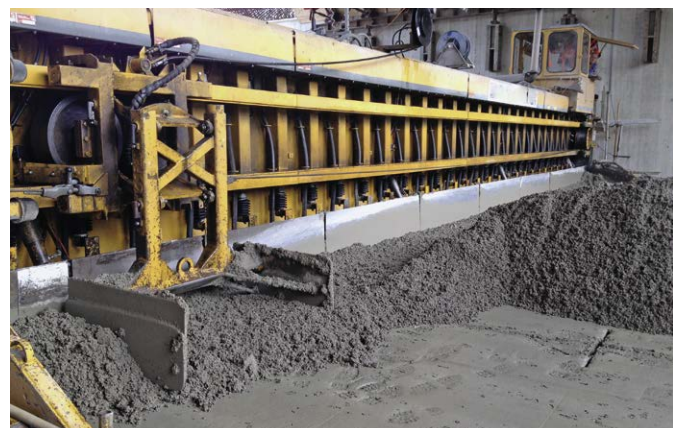
Bild 3: Einbau des Oberbetons, zweischichtige Bauweise
