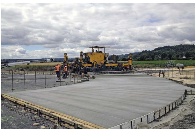
Bild 7: Herstellung einer Beton-Kreisverkehrsfläche mit Fertiger
