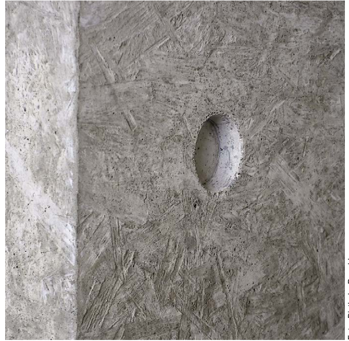
Bild 6: Mit OSB-Platten geschalte Oberfläche mit Kante
