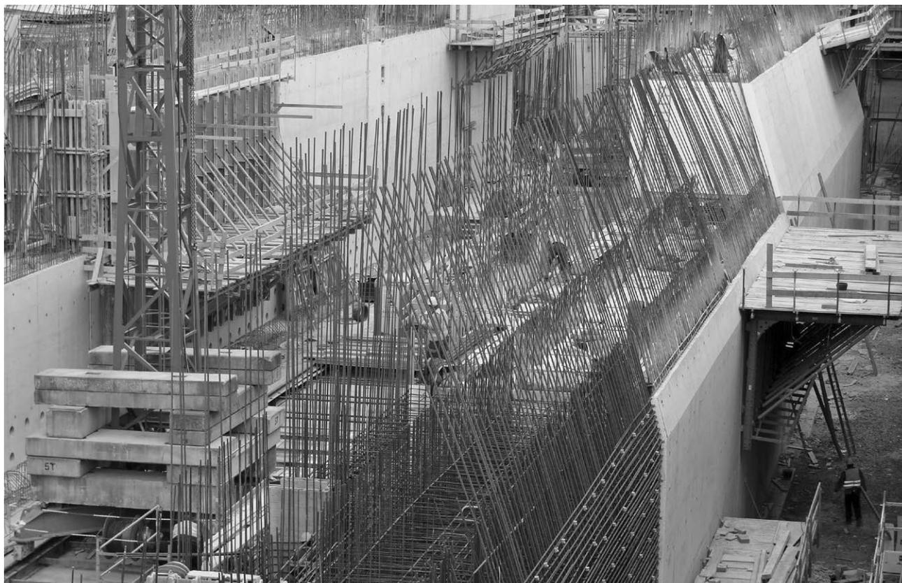
Bild 1: Massige Stahlbetonteile (Foto: A. Weisner)
