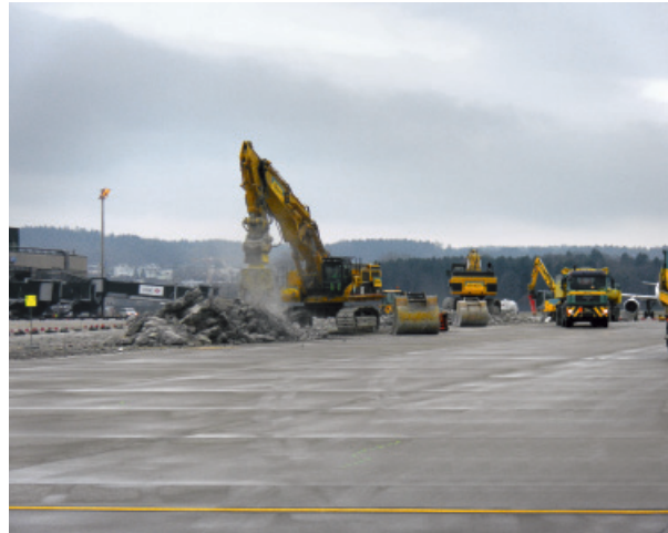
Abbrucharbeiten des bestehenden Betons
