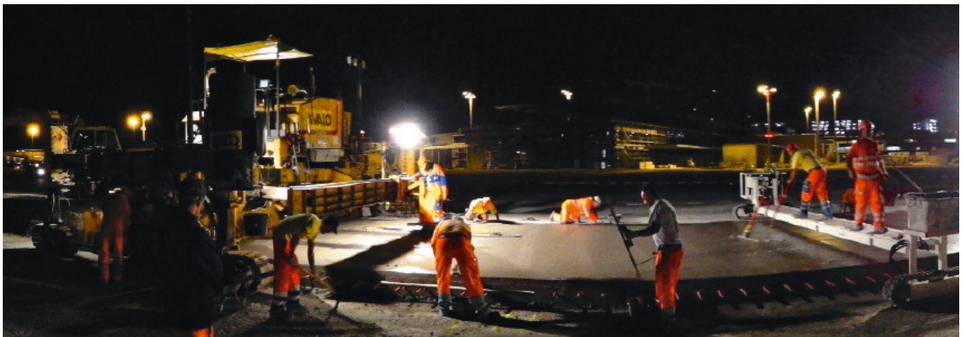
Maschineller Betoneinbau mit Gleitschalungsfertiger
