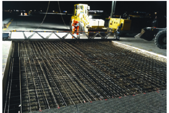
Verlegte Bewehrung für den Schnellbeton
