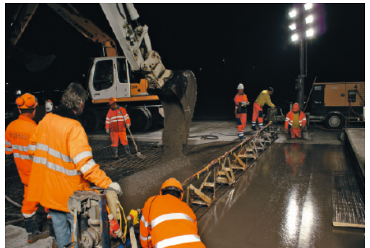
Einbau Schnellbeton (Frühfestigkeit nach 2,5 Stunden: 20\text{ N/mm}^2 )
