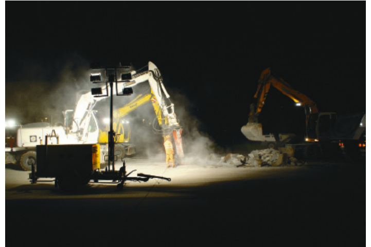
Abbruch während der Nachtphasen auf der Piste
