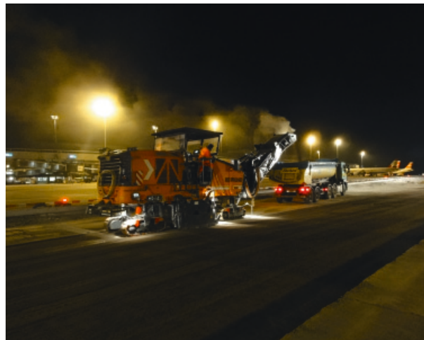
Fräsen der zementstabilisierten Foundation
