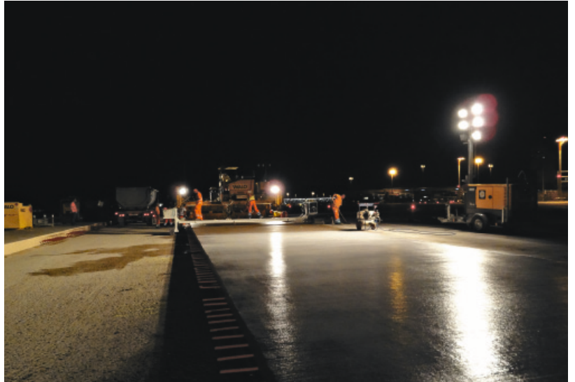
Maschinelles Betoneinbau mit Gleitschalungsfertiger
