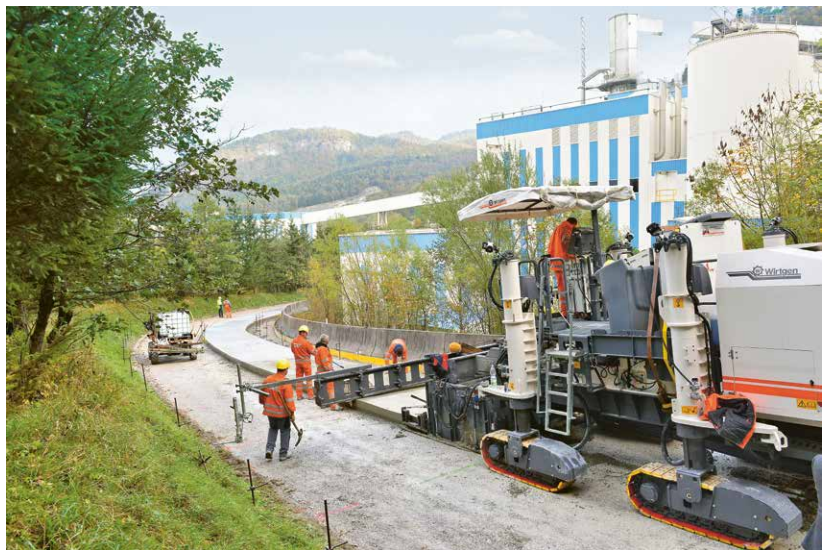
Abbildung 17: Einbau in steilem Gelände
