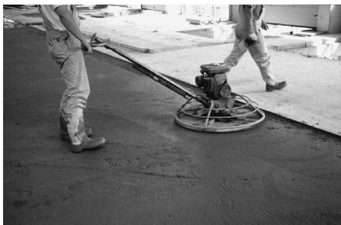
Bild 6: Maschinelles Abscheiben der Betonoberfläche
