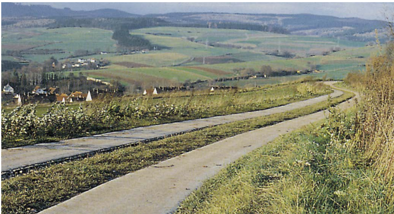
Bild 1: Spurweg aus Ort beton
