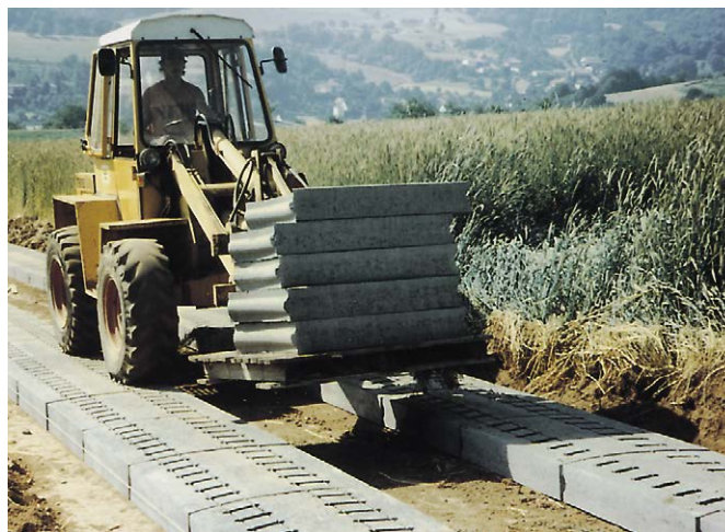
Bild 3: Verlegen von gelochten Spurplatten
