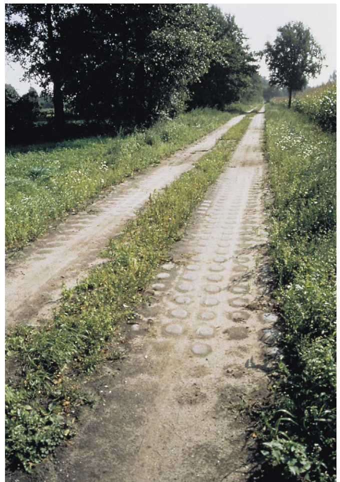
Bild 8: Spurfahrt aus Öko-Pflastersteinen mit Geogitterverbund
