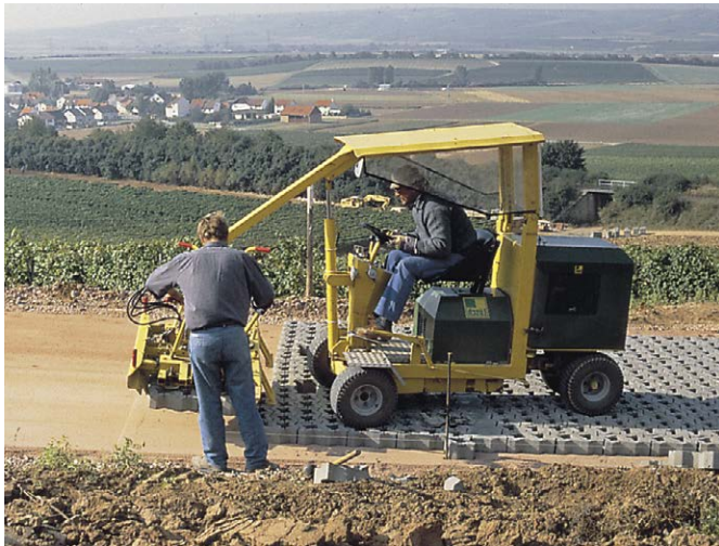
Bild 4: Verlegen von Rasenverbundsteinen mit Verlegemaschine
