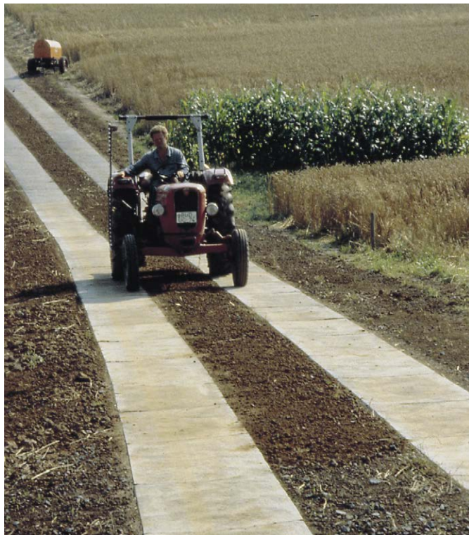
Bild 2: Mit Spurplatten befestigter Spurweg
