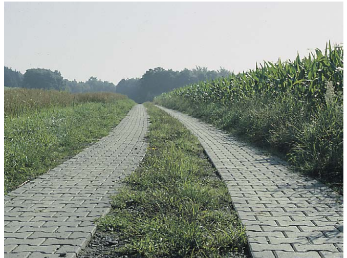
Bild 5: Spurweg aus Verbundsteinpflaster
