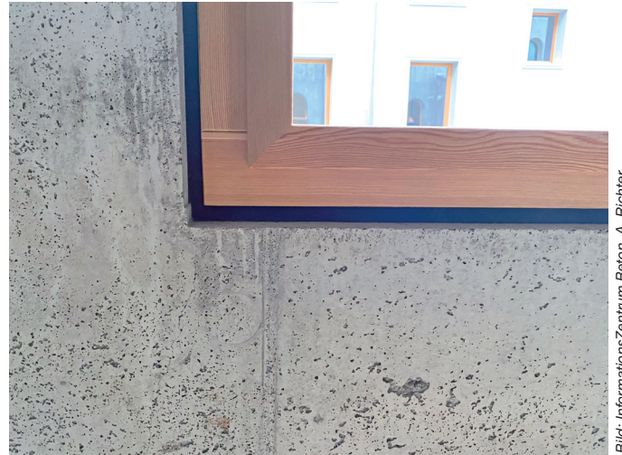
Bild 4: Beispiel für eine typische Oberflächenstruktur eines Infraleichtbetons
