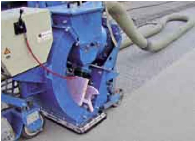
Kugelstrahlen der vermörtelten Fläche
