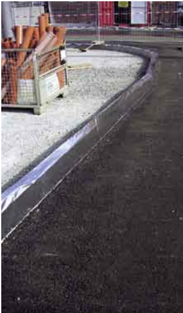
Asphaltträgerüst mit abgedeckter Bordsteinrinne
