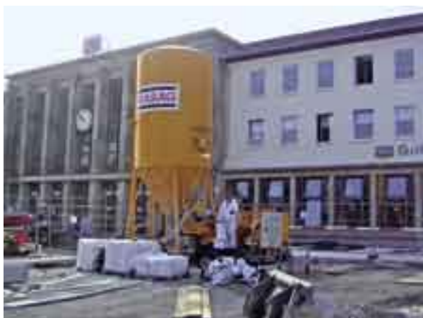
Mischanlage für den Vergussmörtel
