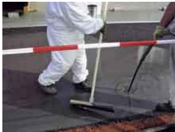
Vergiessen und Verteilen des Mörtels
